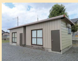
で棟2修 項置の 案物の 懸支の 間の部 長いあ の壁面 を完了 しました。
