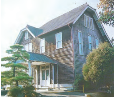
旧畜産試験場本館
