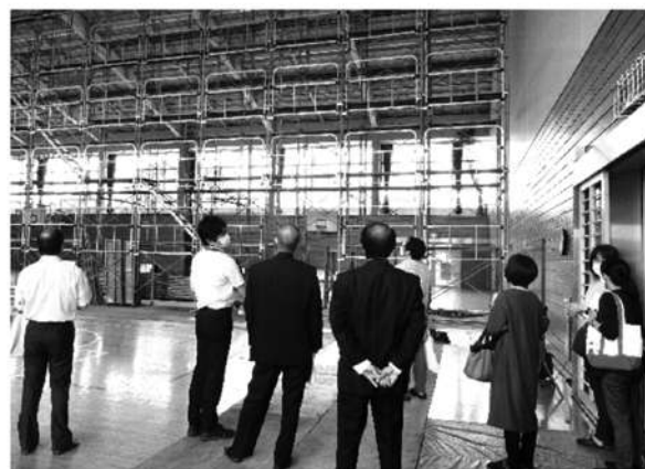
体育館の補修工事の様子を視察する委員
