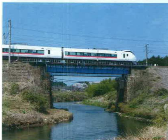
築119年の矢野下鉄橋
