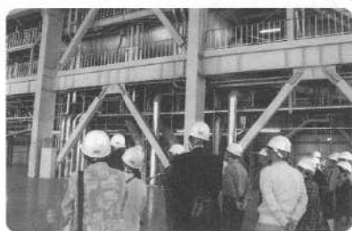
▲ヘルメットをかぶり、蒸気タービンを見る
