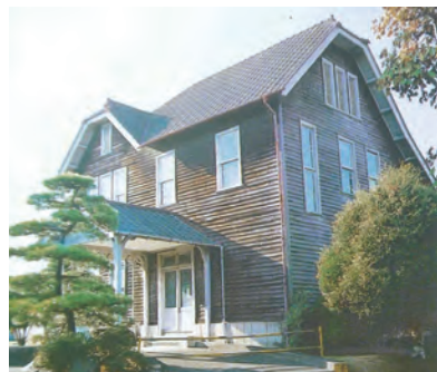
旧畜産試験場本館
